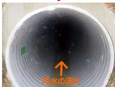
改築後の下水道管
