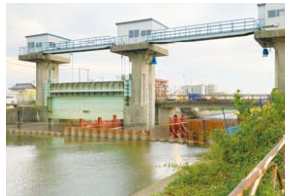
水門の工事を再開した牛久沼の八間堰
