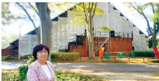
修繕工事中の体育館・プール棟
