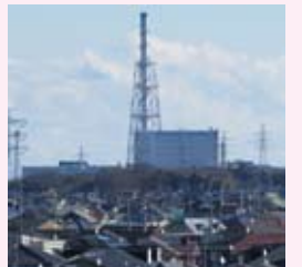
茨城県東海村にある 東海第二原子力発電所
